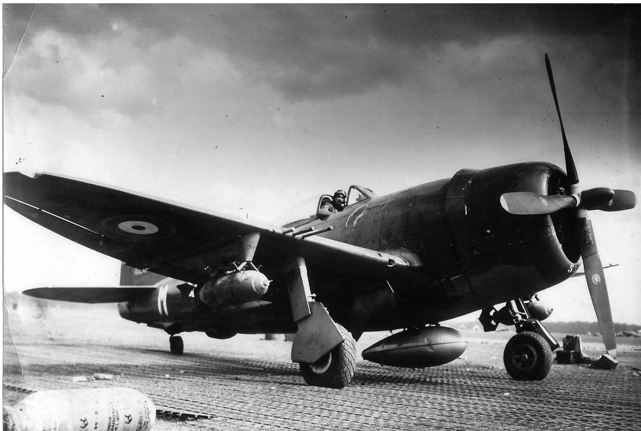
Le P-47 D 26 RA « Bubble-Top » du capitaine Menu, commandant du groupe II/3. Cette version du Thunderbolt se caractérise par le cockpit en forme de goutte d'eau, offrant une meilleure visibilité au pilote. Notez les deux bombes de 500 livres sous les ailes, et le réservoir auxiliaire de 75 gallons (Collection Menu).
