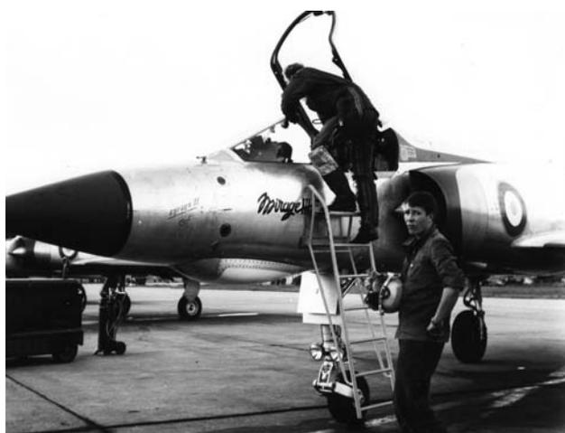
*C'est le 3 mai 1967 que le « Dauphiné » est déclaré opérationnel sur Mirage III E. Son radar CSF Cyrano lui permet d'exécuter de façon autonome des missions de pénétration à basse altitude grâce à ses modes de découpe et d'évitement de terrain. Le doppler monté sous le nez permet au pilote de calculer les dérives et de recalculer sa navigation lors de la mission (Collection BA 116).*
