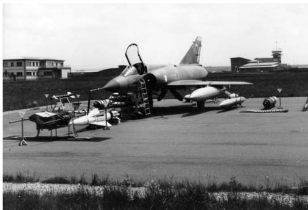
*Cette photo permet de distinguer la panoplie standard mise en œuvre par l'unité dans le milieu des années 1970. On note les réservoirs lance-roquettes JL 100 et le missile air-sol AS 30, dont l'emploi en mode manuel était particulièrement délicat (Collection BA 116).*
